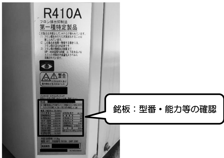
図 2-5 熱源機の型番表示の例（パッケージエアコンディショナ（空冷式））
