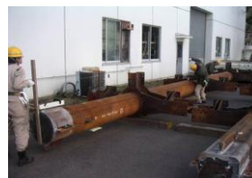
写真-7 柱の測定状況
