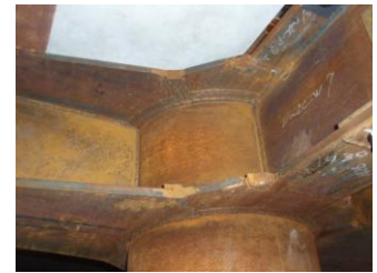
写真-2 柱梁接合部の加力後の状況 (震度7加力)
