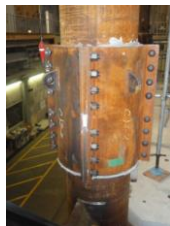
写真-6 柱柱接合部の加力後の状況
