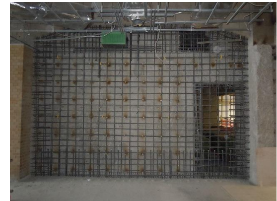
増設耐震補強壁
