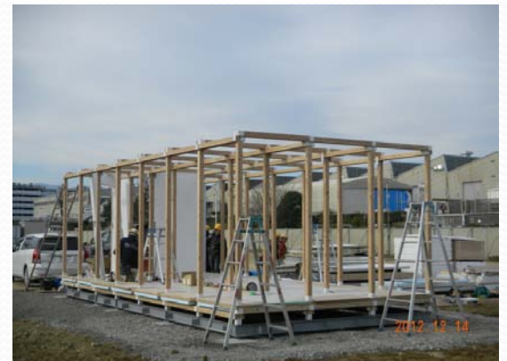
重機無しでの施工状況
