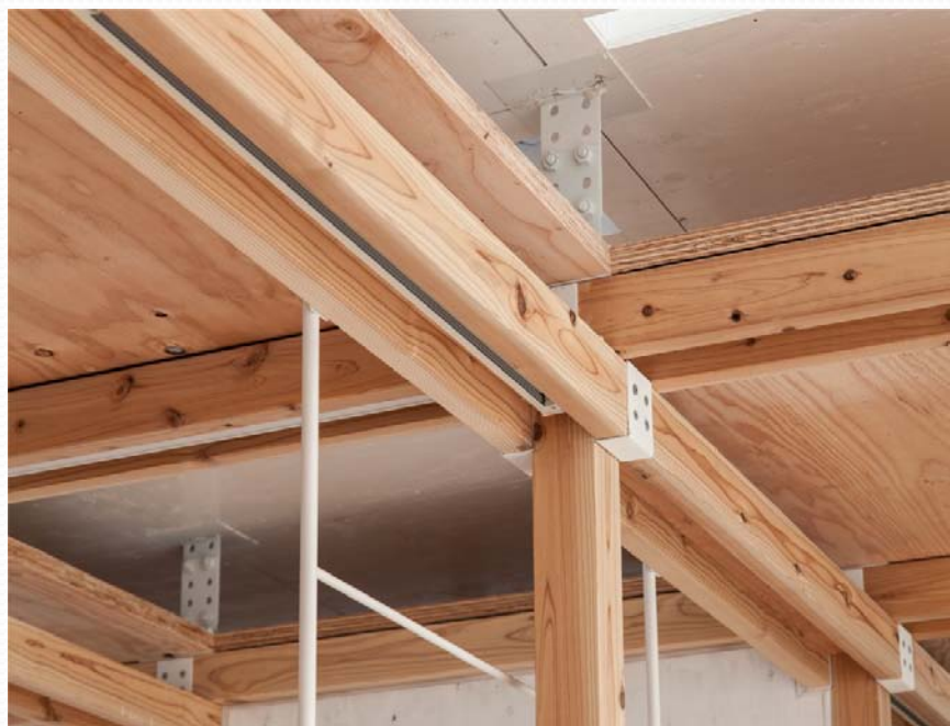
解体可能な柱梁接合金物
