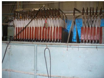
固液分離(フィルタープレス)
