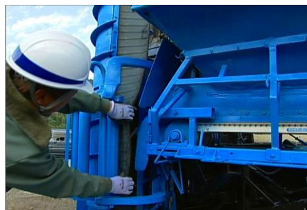
ケーシング側面から砕石投入
