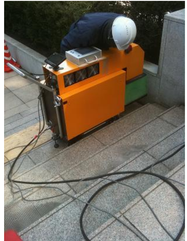
階段への施工(於 新宿・損保ジャパンビル)
