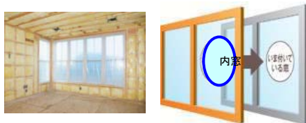
天井・壁等の断熱改修工事 窓の断熱改修工事
