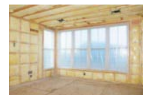
天井・壁等の 断熱改修工事
