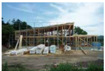
「構造の安定性」の評価は等級2。建築基準法で定められた性能の約1.25倍の強さを持ちます。「住宅性能表示制度」を活用したことにより、家の性能がわかりやすくなりました。
