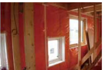
壁の中には十分な断熱材。寒冷地では気密性・断熱性の重要性が特に高く、省エネと快適さを両立しています。
