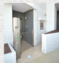
マンションなどでは、設備や階段・廊下などの共用部分も検査を受ける事ができます。
