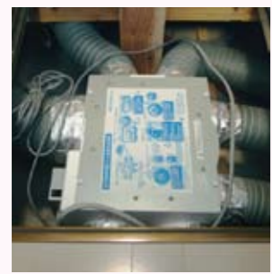
機械でお部屋の空気を循環させる事により、湿度を保ち、建物の劣化を軽減させます。
