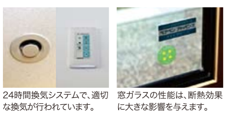
24時間換気システムで、適切な換気が行われています。 窓ガラスの性能は、断熱効果に大きな影響を与えます。
