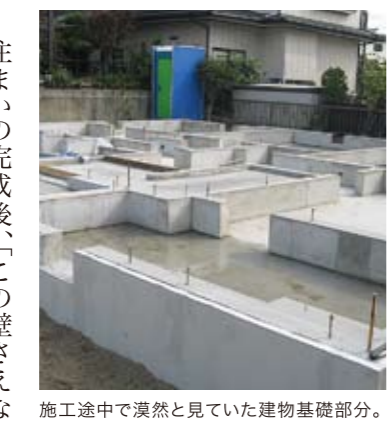
施工途中で漠然と見ていた建物基礎部分。
