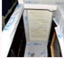
断熱性の高い発泡ウレタンの上に、湿気を逃がす透湿シートを貼っています。
