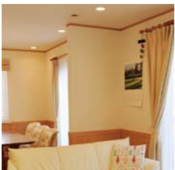
リビングとダイニングの間にある邪魔だと思っていた耐震壁が、構造上重要な部分でした。
