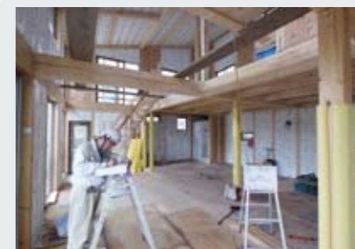
内装下地張りの直前の工事の完了時 第3回目現場検査 温熱環境に関する検査が中心です。断熱材、防湿フィルム等の施工状況、開口部の断熱性能、日射取得などをチェックします。
