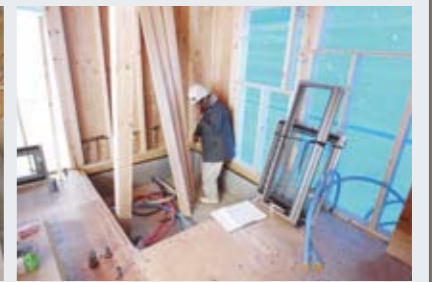
躯体工の完了後 第2回目現場検査 躯体に関しては、特に時間をかけて綿密にチェックします。評価員の目視、計測だけで把握できないものには、部材メーカーが発行した納品書、認定書などを提示してもらいます。
