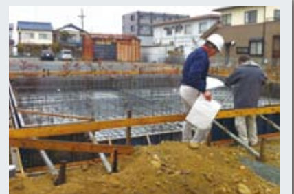
基礎配筋工の完了時 第1回目現場検査 建物の配置、基礎幅、鉄筋の結紮、基礎の高さなどをチェックします。
