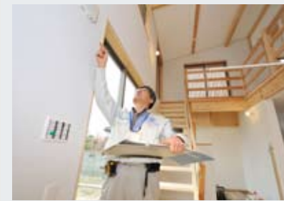
竣工時 第4回目現場検査 空気環境、高齢者等への配慮の等級が検査されます。これまでの変更箇所の追加写真や書類は揃っているか、もし足りないものがあれば、後日提出してもらうよう促します。
