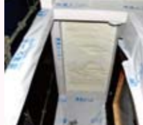
断熱性の高い発泡ウレタンの上に、湿気を逃がす透湿シートを貼っています。
