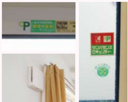
防犯に関する各部材の性能の証明(CP部品)と、24時間対応の換気扇です。
