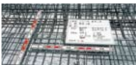
正確に計算された密度の濃い基礎配筋
