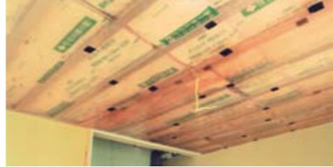
普段は見えない天井の断熱材。
