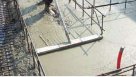
施工過程もしっかりと記録
