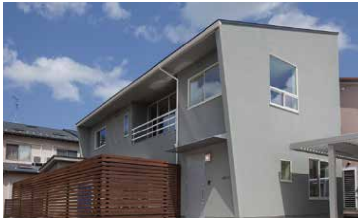
外観はシックにまとめ屋根には太陽光パネル設置で自家発電
