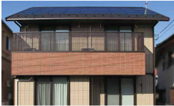
長期優良住宅認定制度の要件にあてはまる外壁と太陽光発電などを取り入れた外装
