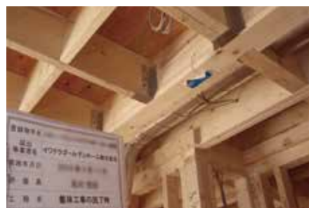
桁組材にはしっかりと受け金物で固定されている
